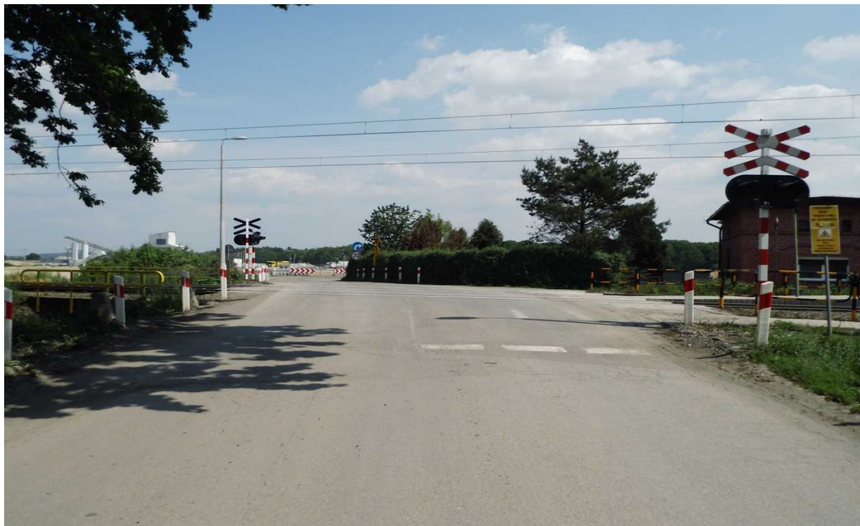
Zdjęcie nr 4. Przejazd kat. C od zachodniej strony (od m. Tworków) droga powiatowa DP 3517 S – Tworków, na linii kolejowej nr 151. Brak linii P-4 (podwójna ciągła) po obu stronach, wytarta częściowo linia P-14 (linia warunkowego zatrzymania złożona z prostokątów).
