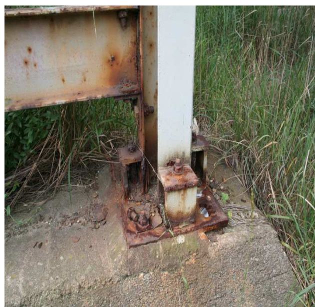
Zdjęcia nr 26 i 27. Kładka w Brzegu Dolnym, pomiędzy ulicami Sienkiewicz i 1 Maja. Perforacja na stężeniach belek. Poziome blachy słupów podpór uległy rozwarstwieniu (znaczne ubytki korozyjne przekrojów stalowych).
