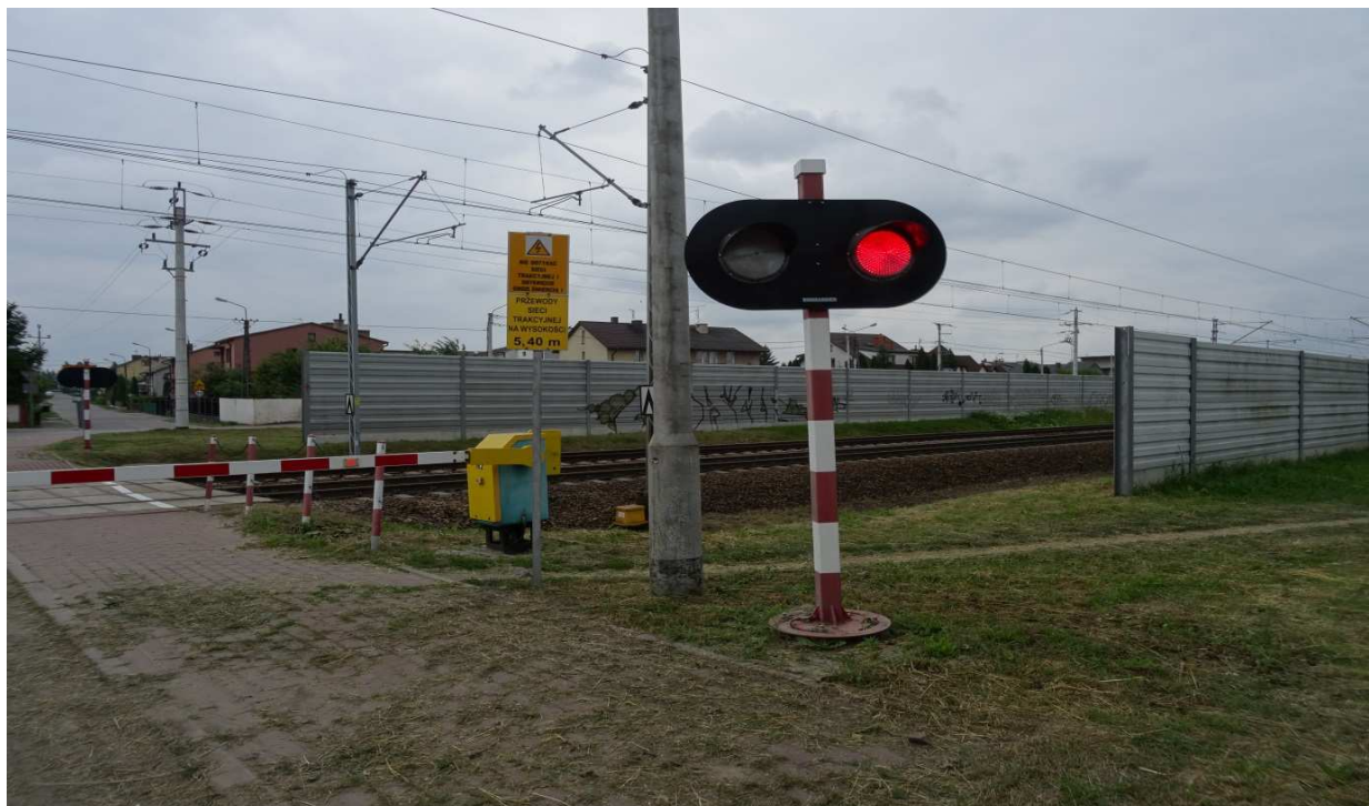
Zdjęcie nr 11. Linia kolejowa nr 002 Warszawa – Terespol, przejazd w km 90,862. Utrudniona widzialność pociągów z drogi. Przeszkody stanowią kontener srk oraz ekrany dźwiękochłonne.
