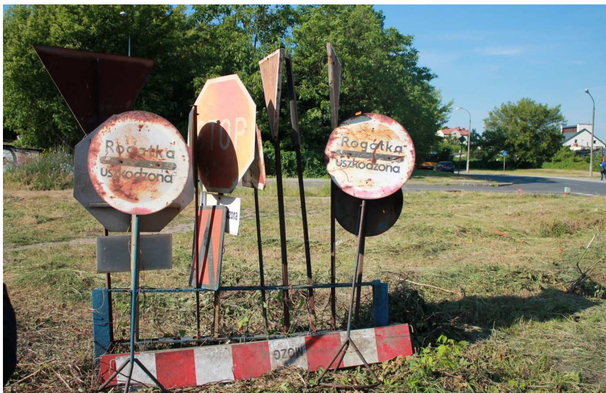
Zdjęcie nr 9. Bałagan na posterunku dróżnika. Nieodnowione tarcze i wskaźniki będące na wyposażeniu przejazdu kolejowo-drogowego w Warszawie w km 8,452, na linii kolejowej nr 007, szlak Warszawa Wschodnia Osobowa – Wawer.
