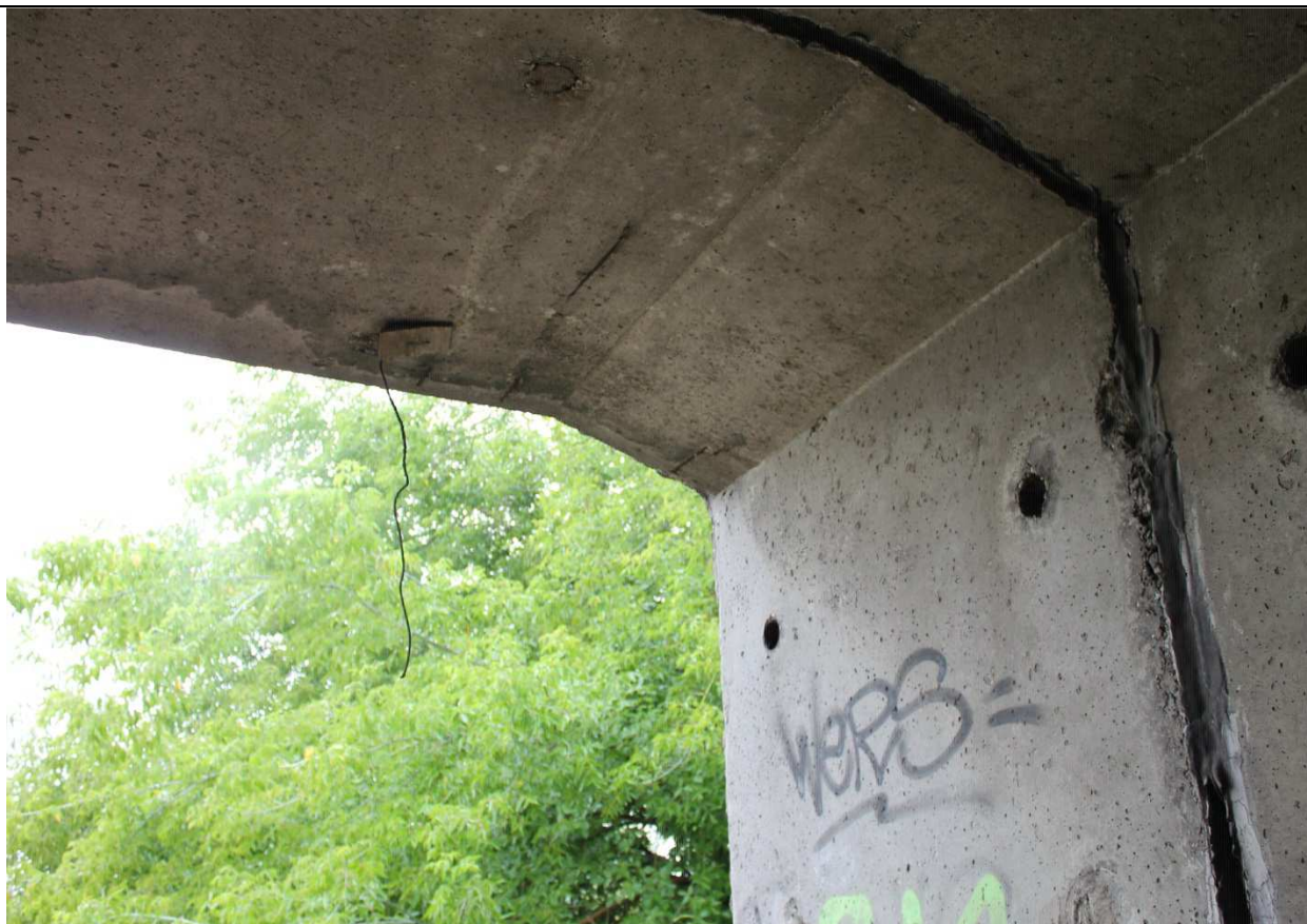
Zdjęcie nr 38. Przejście dla pieszych przy przystanku PKP Warszawa Żerań przy ul. Płochocińskiej. Zwisający niezabezpieczony przewód elektryczny.
