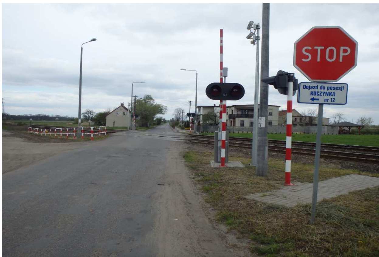
Zdjęcie nr 3. Przejazd kat. B na linii 134 Jaworzno Szczakowa – Mysłowice w km 199,279. Niekompletne oznakowanie drogowe, brak słupków prowadzących (pachołków) po obu stronach drogi.
