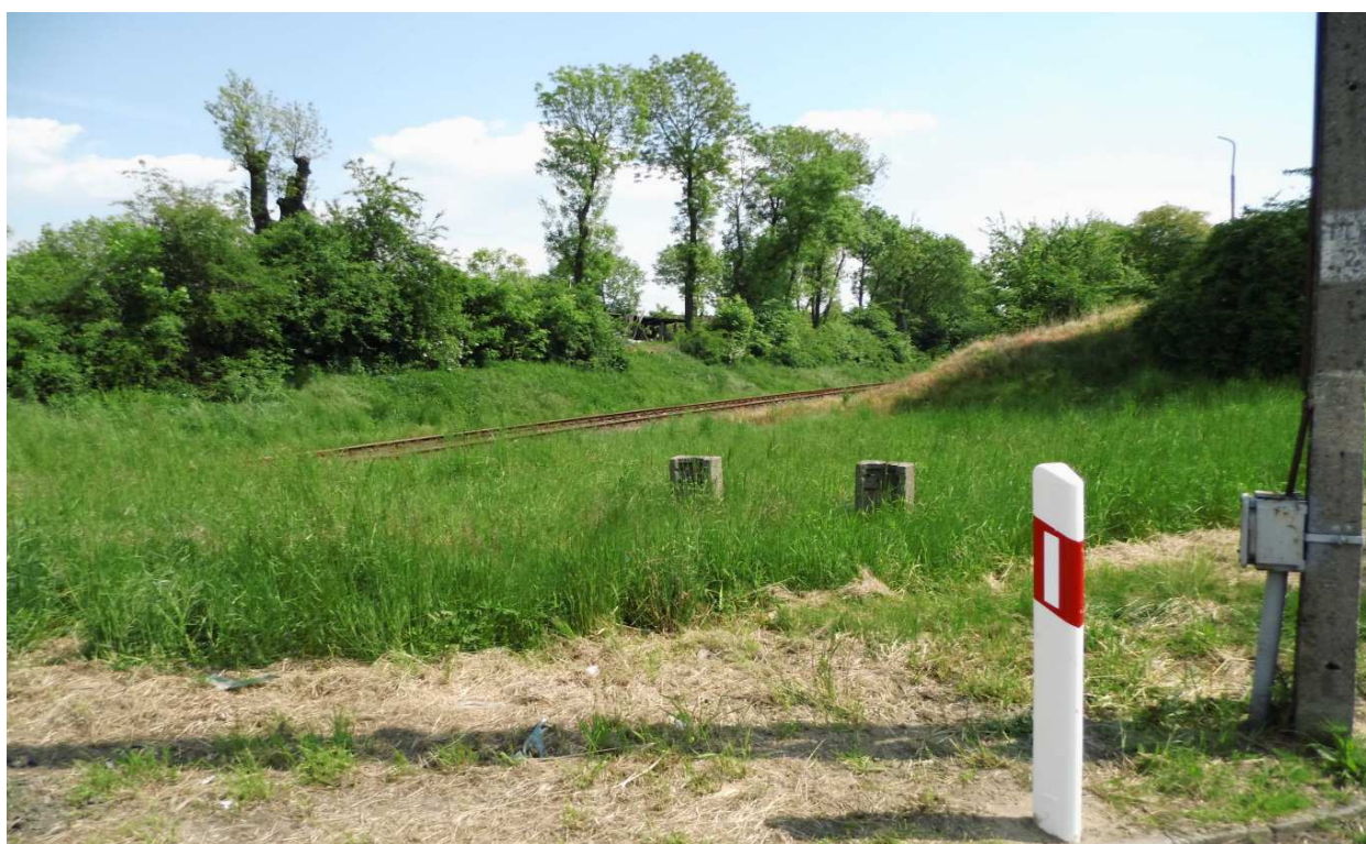
Zdjęcie nr 12. Przejazd kat. D na linii kolejowej nr 177 w Wojnowicach. Brak pola widoczności na dojeździe od południowej strony w kierunku Raciborza.
