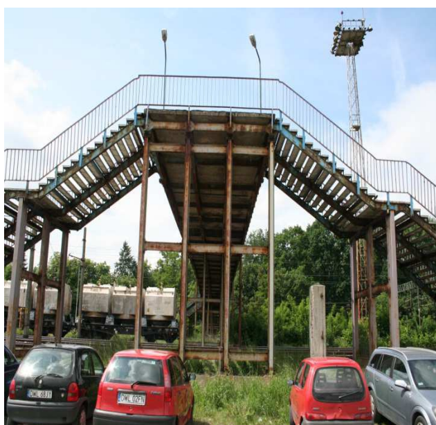
Zdjęcia nr 26 i 27. Kładka w Brzegu Dolnym, pomiędzy ulicami Sienkiewicz i 1 Maja. Perforacja na stężeniach belek. Poziome blachy słupów podpór uległy rozwarstwieniu (znaczne ubytki korozyjne przekrojów stalowych).
